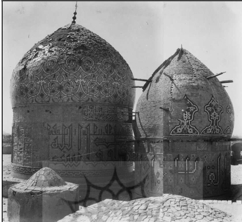
تصویر ۱- گنبدهای بنای درب امام اصفهان مربوط به دوره صفوی و تیموری گنبد سمت راست به شیوه نره و گنبد سمت چپ به شیوه معرق کاشی اجرا شده است (مأخذ: روبرت بایرون بنیاد آقاخان)
