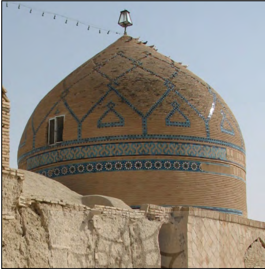
تصویر ۹- اجرای تزئینات گنبد مسجد جامع ورزنه اصفهان با کاشی معقلی
