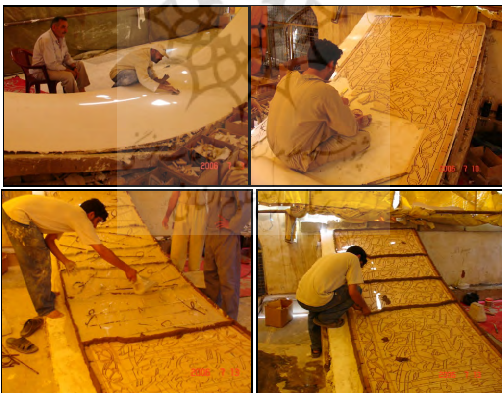
تصویر ۷- مراحل اجرای ساقه گنبد امام جواد(ع)
